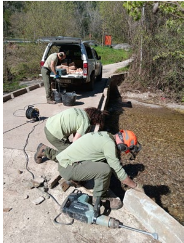
Arranjament dels bordons de la passera de les Arenes fets malbé per les riuades. Font: Arxiu XPN
