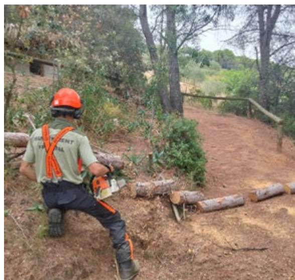
Retirada d'arbres a la xarxa viària. Font: Arxiu XPN
