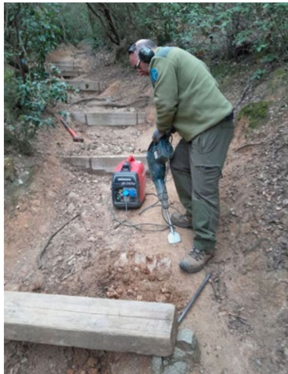
Reparació dels esglaons de l'itinerari. Font: Arxiu XPN
