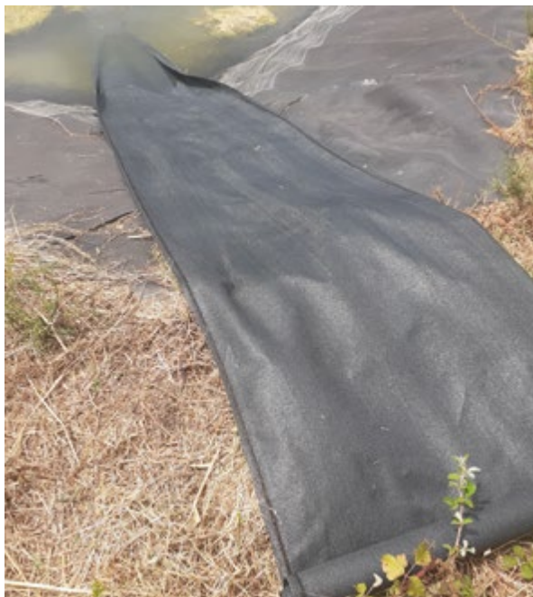
Reparació de les rampes de les basses. Font: Arxiu XPM
